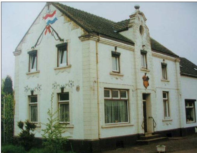
Pronkgevel Bornerweg Obbicht
