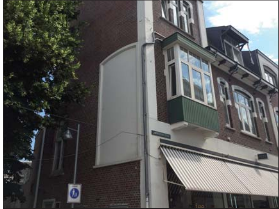
Een niet meer voor reclame in gebruik zijnde groot wit omlijst vak aan het pand Limbrichterstraat 79
