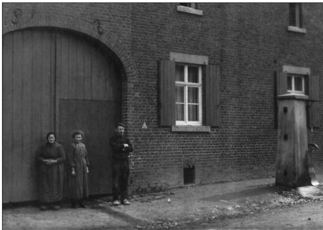
Oude waterpomp Dorpsstraat 17 in Guttecoven
