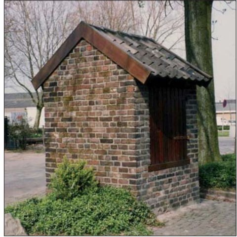
De waterput in Lutterade na de restauratie
